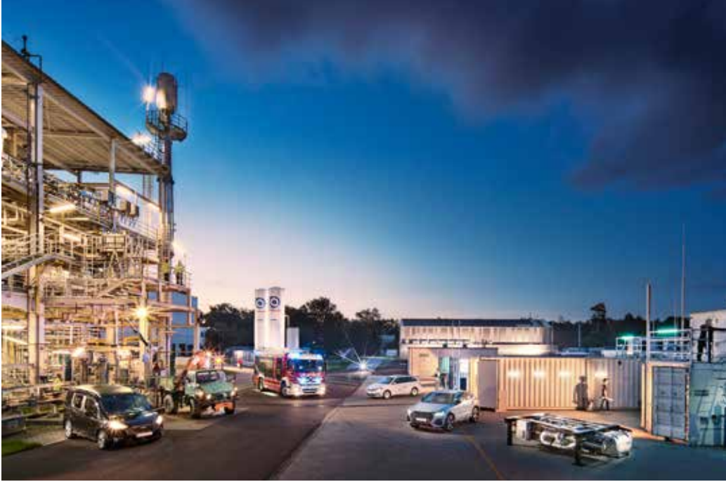
Pilotanlage für neue Kraftstoffe am KIT Campus Nord. Foto: Amadeus Bramsiepe © copyright by Karlsruher Institut für Technologie
